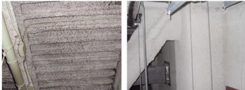
図-5.5.2 アスベスト使用箇所例（石綿含有吹付け建材・ロックウール）
